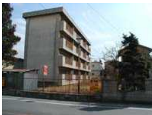
空き家の教職員住宅 鷹野5丁目
