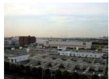
東京都浄水場
