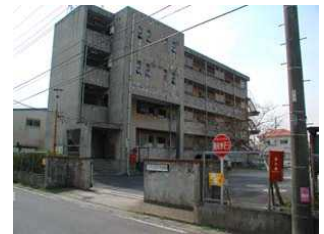
老朽化した職員住宅 長戸呂
