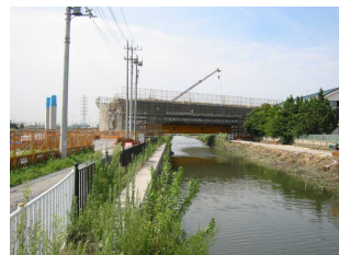
工事が進む中央地区
