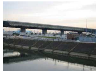
工事中の外環道
