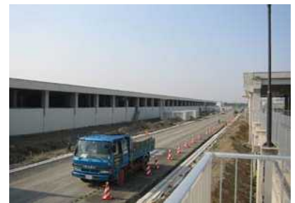
完成した6.9畝のデッキ
