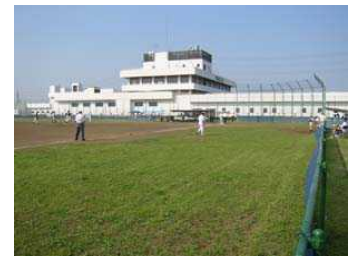
東京都清瀬市にある処理場上部の野球場
