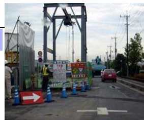
下水道工事現場 (彦成地区)
