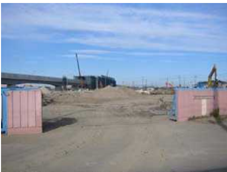
解体された新和小学校
